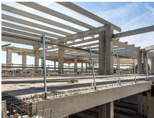
Crédit photo KP1 - Plancher haut KP1
