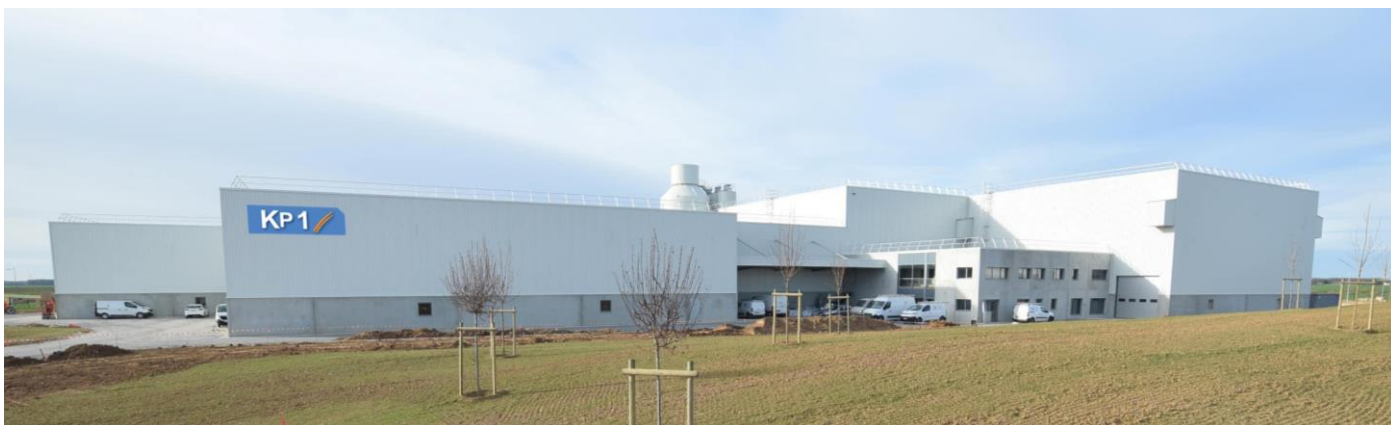
Usine de prémurs KP1, Vernouillet - Crédit photo KP1
